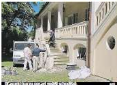
Účastníci kurzu opraví vnější schodiště.
